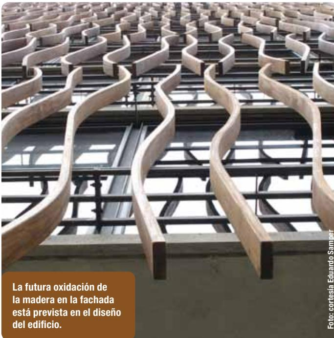
La futura oxidación de la madera en la fachada está prevista en el diseño del edificio.
